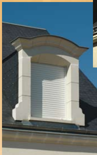
Lucarne chapeau de gendarme (jambages avec faux joints)
