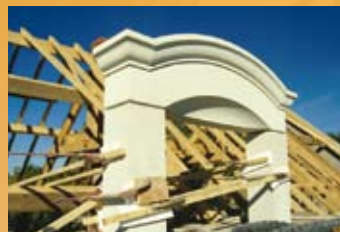
Mise en œuvre lucarne chapeau de gendarme
