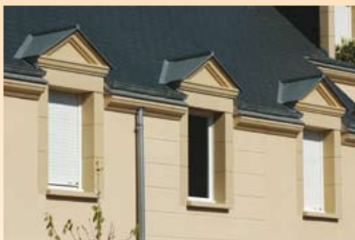
Lucarnes à fronton (pose en gerbière)
